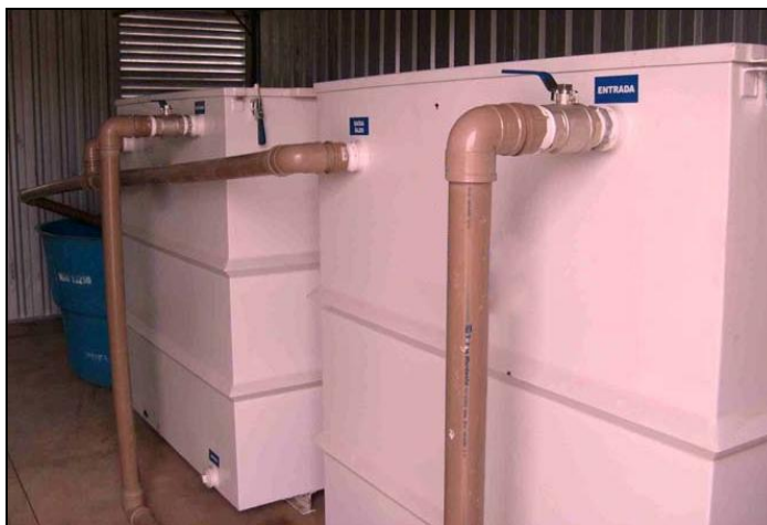
Figura 3.5-7 - Caixas separadoras do Sistema SÃO
